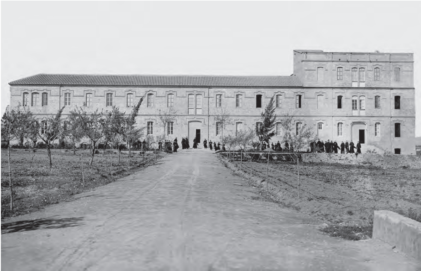
Fachada de la casa hacia 1924, cuando ya había sido construida la Iglesia, pero el resto del edificio constaba tan solo aún de planta baja y un piso.
