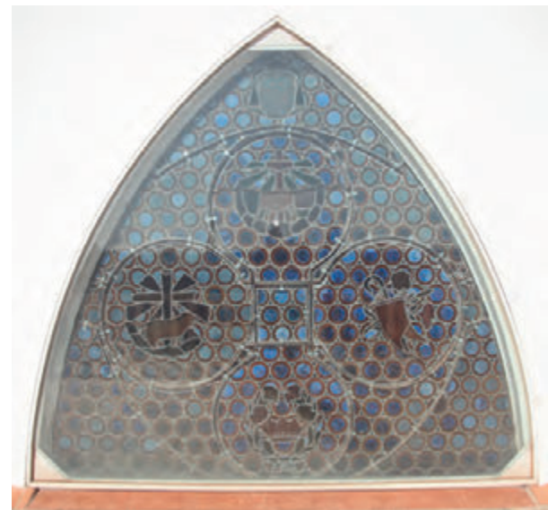
Vidrieras del lado este de la Iglesia, construidas tras la guerra civil y restauradas en 2018.
