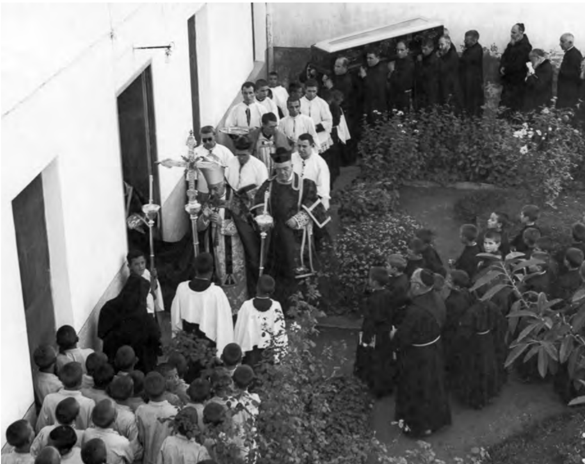
3 de octubre de 1934. Momento en que el clero se dispone a cruzar la puerta que comunica el patio central de la Casa de las Hermanas en Masamagrell, con el corredor que lleva a la Capilla.
