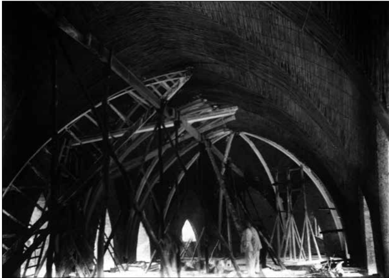
Construcción de la bóveda de la Iglesia de la Colonia de San Hermenegildo, de acuerdo a los planos del arquitecto Manuel Peris adaptados por el también arquitecto, el castellanense Vicente Traver.
